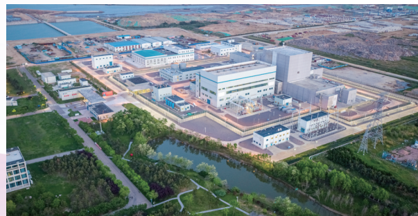
清华大学牵头设计的石岛湾高温气冷堆核电站全景。
