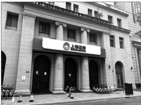
九江路41号原花旗大厦现状
